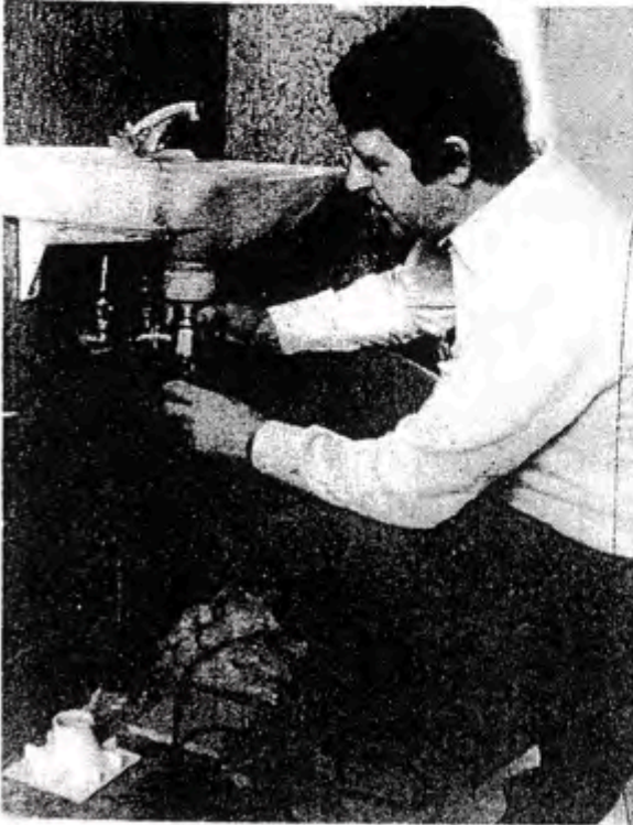
Kun rengøring og småting manglede, da Se & Køb besøgte det nye spejdercenter i fredags. Her er O. B. Sørensen ved at kontrollere en vandlås.
